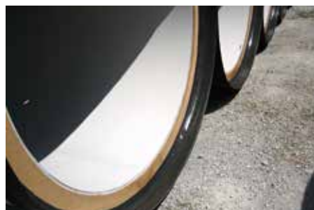
TS シールを下水道管端面に充填
