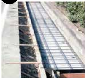
側溝のコンクリート蓋の埋設型枠
