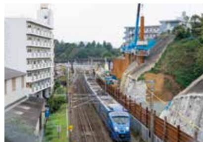
鉄道近接での切土擁壁構築工事
