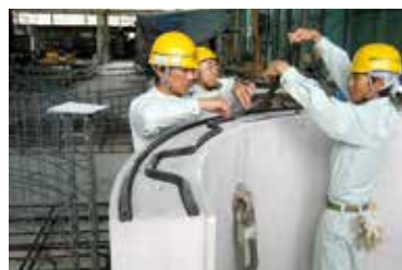
落差マンホール接合用 TS シールテープの貼り付け作業
