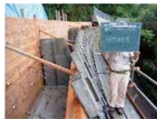
目地部に使われる木製型枠の代替材の埋設型枠
