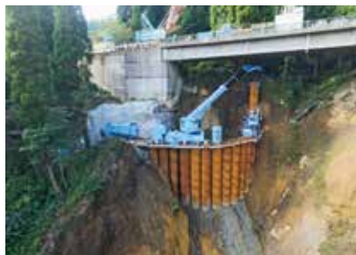
被災した橋脚の緊急補強工事
