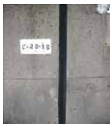
防潮堤の目地に充填
